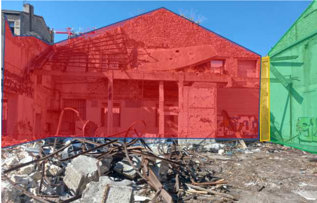
Figure 6 – Phase déconstruction – côté NORD
